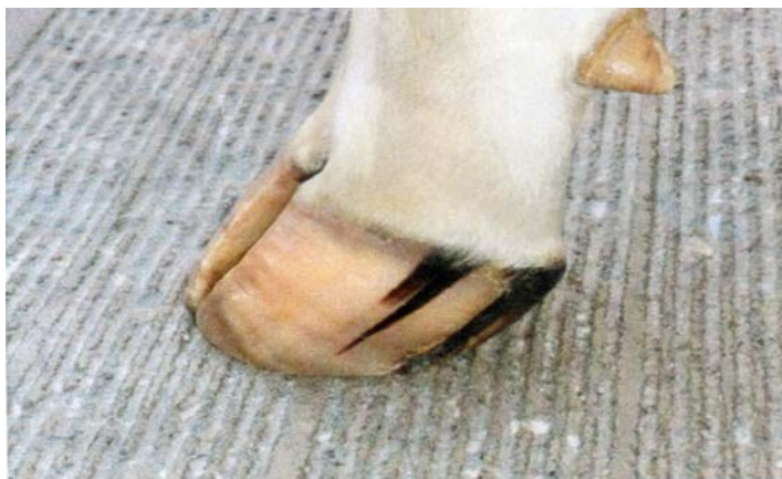
Рисунок 10 – Продольная насечка с узкими и частыми канавками
