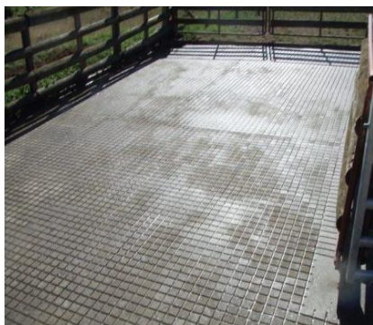
Рисунок 9 – Продольная и поперечная насечка с узкими канавками
