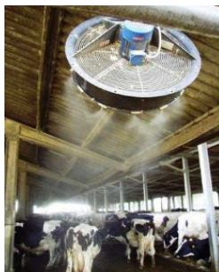
Рисунок 32 – Принцип действия системы распыления воды под высоким давлением
