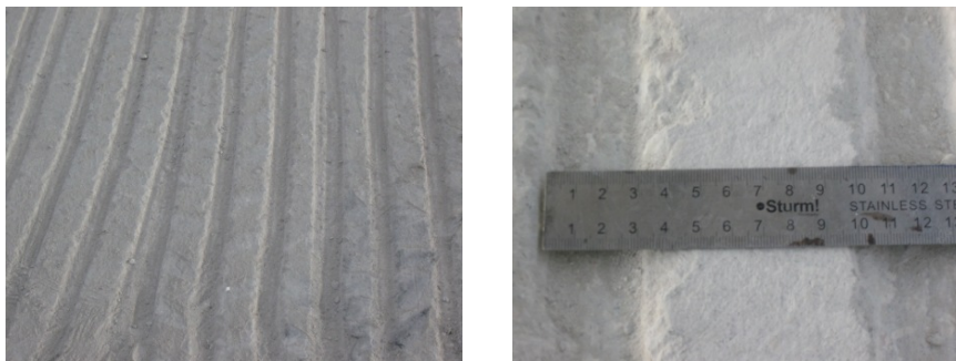
Рисунок 8 – Продольная насечка с широкими канавками
