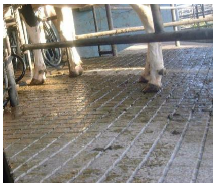
Рисунок 9 – Продольная и поперечная насечка с узкими канавками
